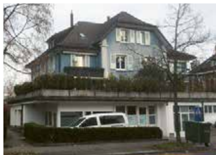
Fellenbergstrasse 246 (linke Hälfte)
