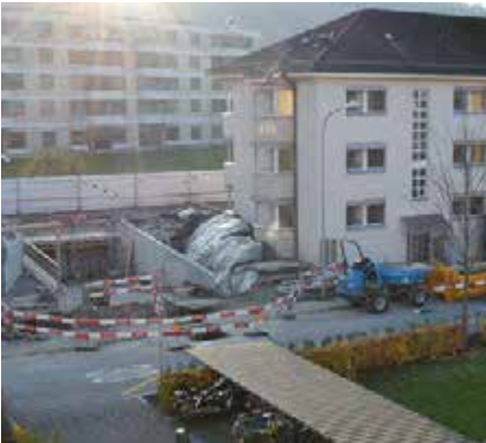
Rückbau des Gebäudes hat begonnen
