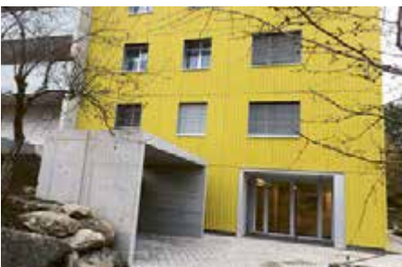
Neuer Eingangsbereich mit Velounterstand
