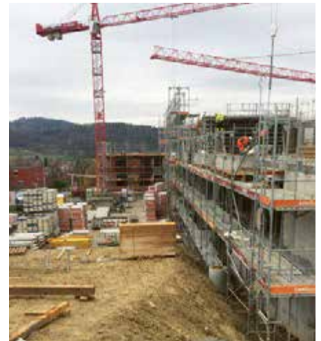
Baugrube im August
