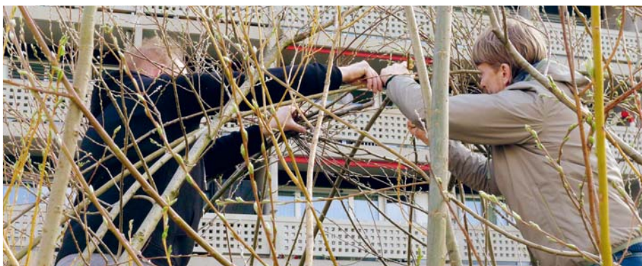
Die Instandsetzung erfordert Geschick und Zusammenarbeit
